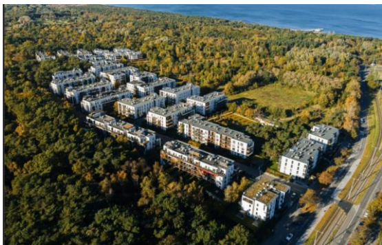
fot. widok na osiedle z lotu ptaka
